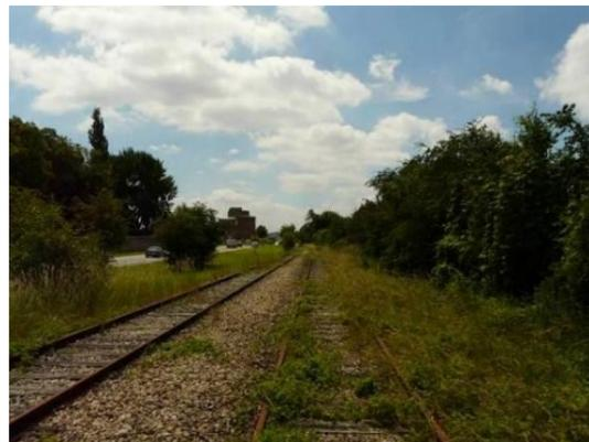
Figure 116 : Progression de la végétation sur le ballast au long du parc de Versailles
